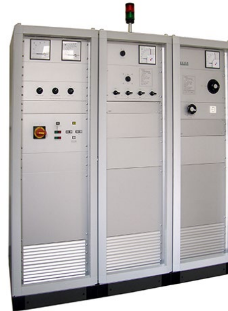
VRT Transformatorische Quelle max. 400 V, Netzfrequenz
