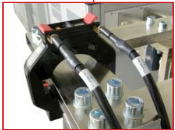
Detailansicht eines Prüflings (CT) sekundärseitig angeschlossen.
